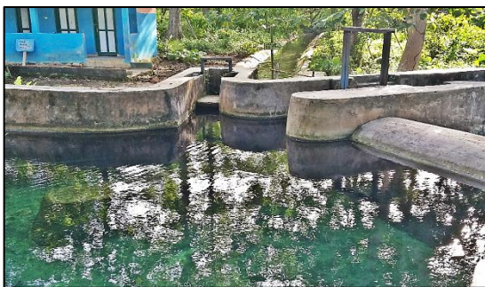
Gambar 2. Pengontrol Aliran ( Bendungan Mataompana ).
